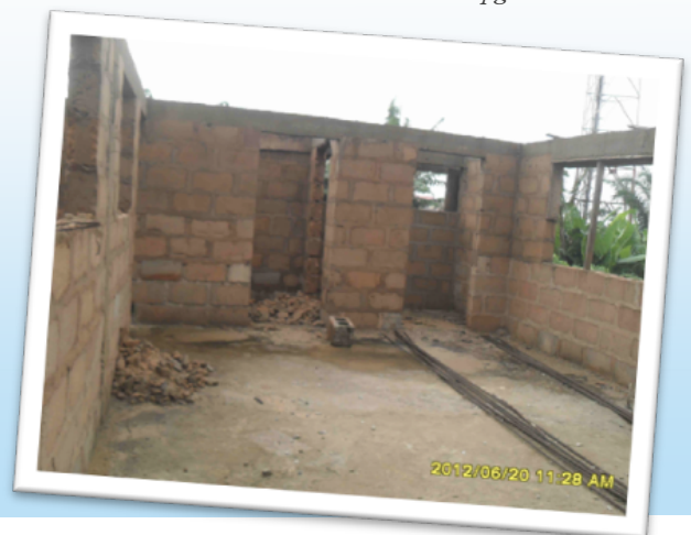
... en het nieuwe slaapgebouw in aanbouw!
